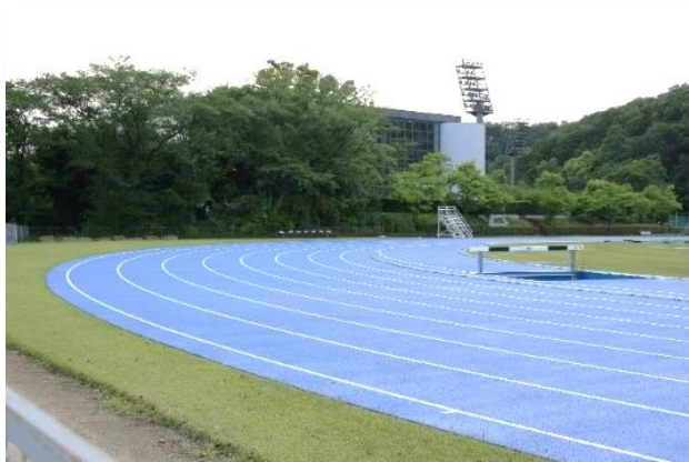
多摩キャンパス 改修後の陸上競技場
